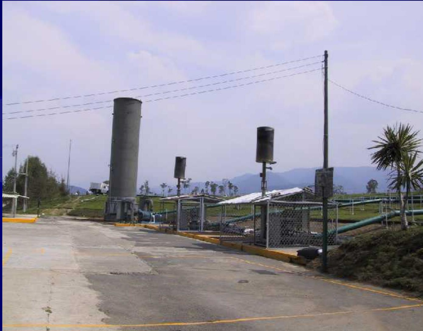
QUEMADOR DE 2300 FT<sup>3</sup>/MIN Y QUEMADOR DE 650 FT<sup>3</sup>/MIN
